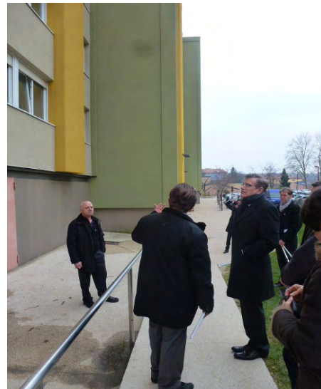
Visite des travaux de rénovation énergétique de la Rue Parant
